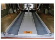
▲機械式駐車場補修(下塗りにサビキラープロ、上塗りに当社製品セラコンハードGEP/GUPを塗装)
